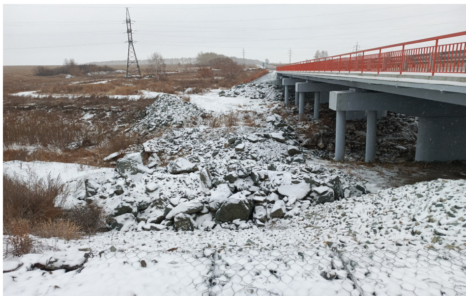
Рисунок 1 – Подводящий канал и паводковый водосброс на реке Ирмень. Вид с подводящей дамбы
